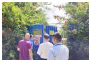
图-海南基地污水站检查
